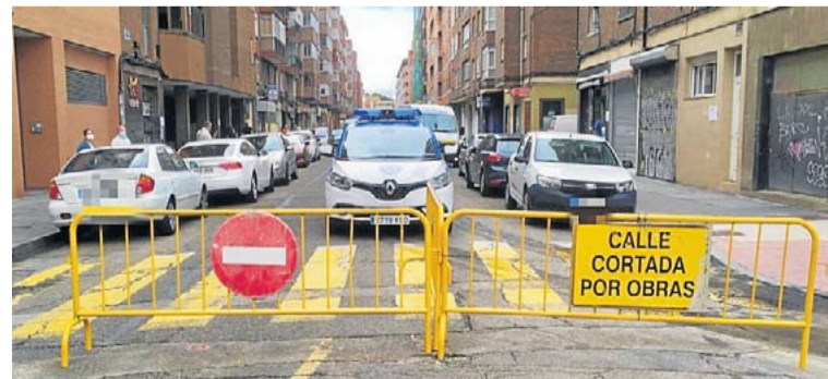
Vallado que indica el corte al tráfico de Nueva del Carmen. EL NORTE
